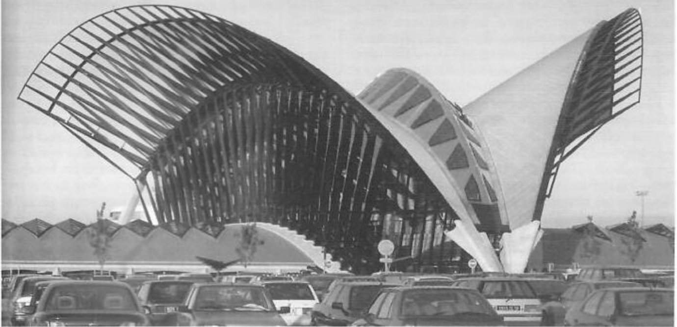
TGV-Bahnhof Lyon-Satolas, oben: Planskizze, Bahnsteighalle
