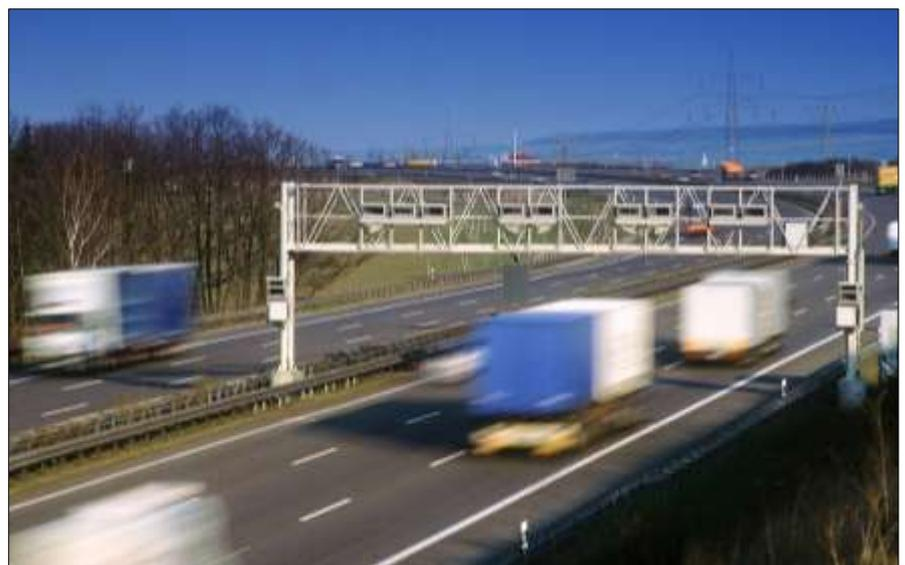
Kontrollbrücken überprüfen automatisch, ob Lkw ins Mautsystem eingebucht sind.
