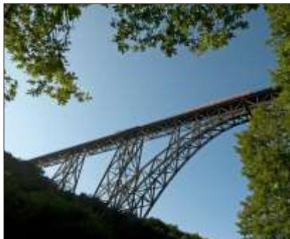
Viele Brücken in Deutschland sind altersbedingt in einem kritischen Zustand. Die Mungstener Brücke bei Solingen (Bild) musste im Herbst 2010 gar für einige Monate komplett gesperrt werden. Derzeit wird die Brücke grundlegend saniert und soll im Dezember 2014 wieder eröffnet werden. Foto: DB AG / Max Lautenschläger.
