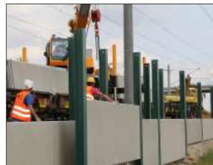
Neben der Lärminderung am Fahrzeug sind weiterhin bauliche Maßnahmen erforderlich. Hier die Installation von Lärmschutzwänden bei Niederklobikau an der Neubaustrecke Halle – Erfurt.
