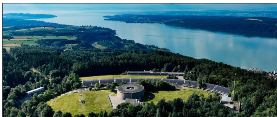
Dass die Wasserversorgung „einfach mal so“ ausfällt? Undenkbar! Aber die Bahn... Aufbereitungsanlage der Bodensee-Wasserversorgung auf dem Sipplinger Berg; Foto: © Zweckverband Bodensee-Wasserversorgung.
