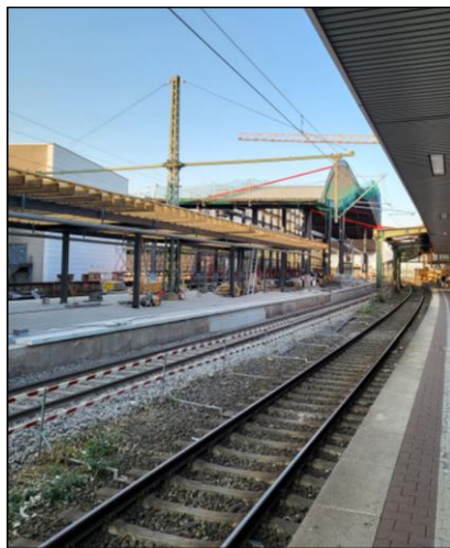
Die Verkehrsstationen sind auch innerhalb der neuen DB Infrago AG in einem selbstständigen Kokon organisiert. Bau einer neuen Bahnsteighalle und Erneuerung der Bahnsteige in Duisburg Hbf, Bauzustand am 16. Juni 2023; Foto: Wolfgang Dietrich Mann
