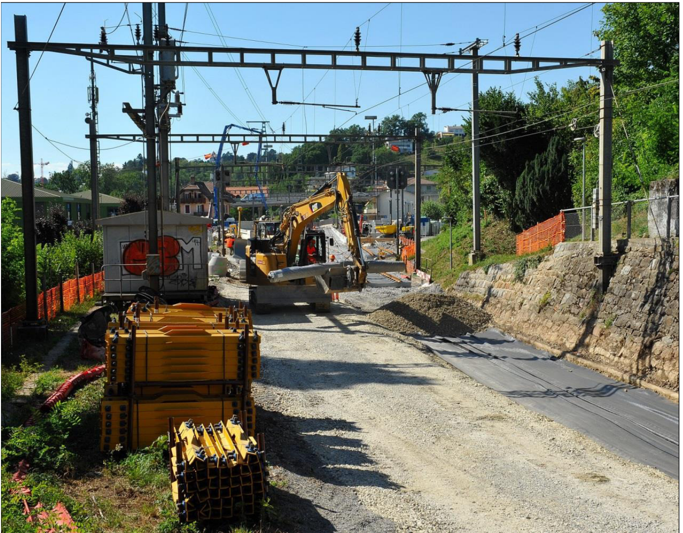
Arbeiten zwischen Puidoux-Chexbres und Lausanne am 26. Juli 2018; Foto: Sylvain Meillasson)
